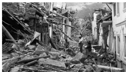
Terremoto en 1970 en Huaráz de 7.9 grados en la escala de Richter, 70,000 muertos
